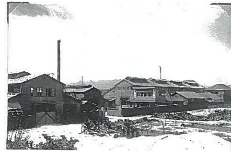
図2 昭和21年の工場遠景
